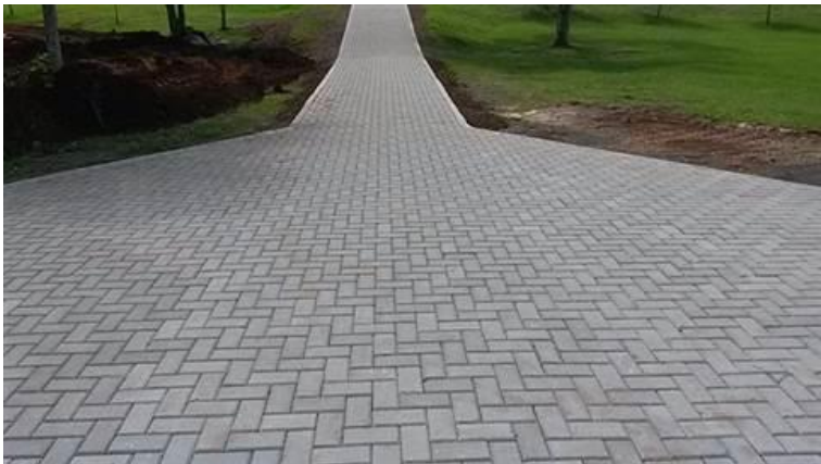
Imagen 40- Adoquín de hormigón / elaboración propia
