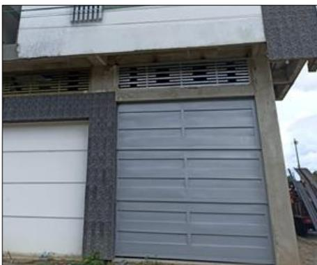
Fig. 5: portón metálico eléctrico ascenso vertical. Fuente: propia
