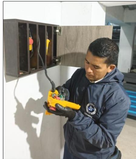
Figura 19. reacondicionamiento control para accionamiento de diferencial eléctrico. Fuente: propia
