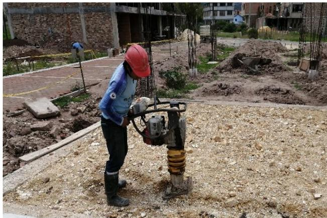
Luego se nivela con más material para terminar de dar la nivelación en ceros con las vigas de cimentación.
