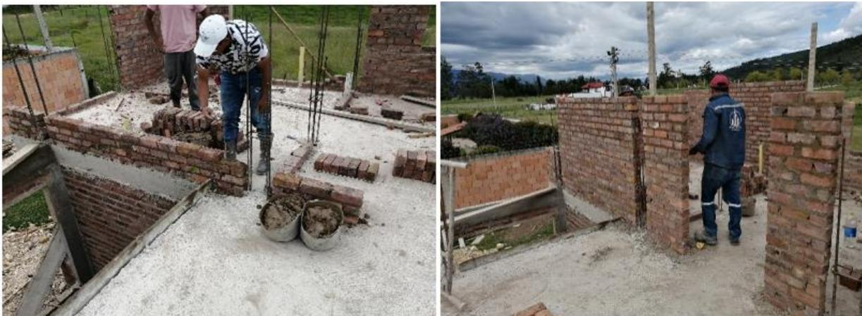
Debido a que algunos muros deben quedar a la vista, se realiza una limpieza en el contorno de pegado del mortero para realzar su textura; por ello, es necesario que esta
