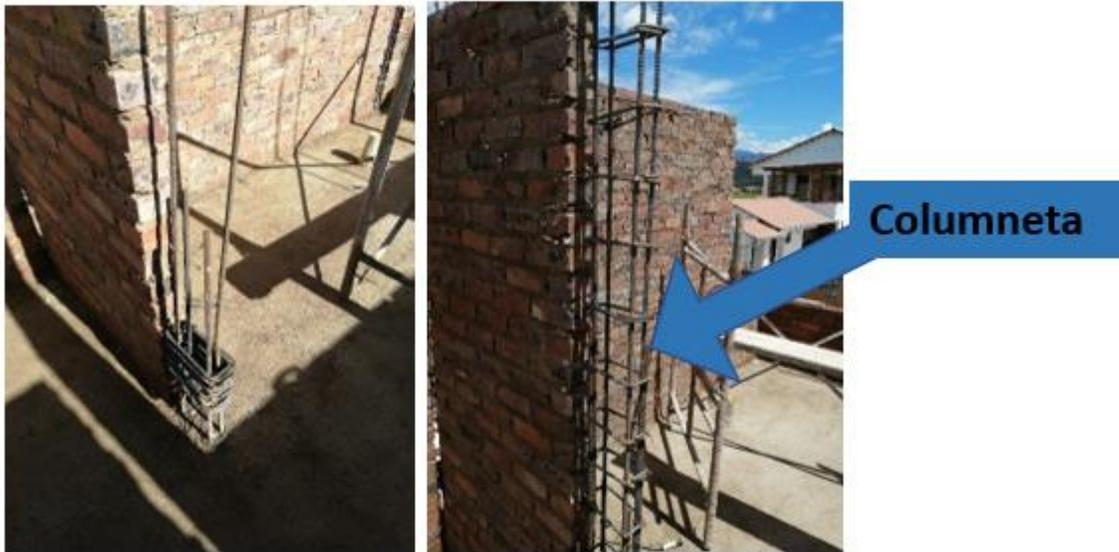
De esta manera se arman 18 columnas de confinamiento para posteriormente realizarse la fundida de estos elementos. Para ello, se utilizó encofrado en madera y concreto con una dosificación para 3000PSI.
