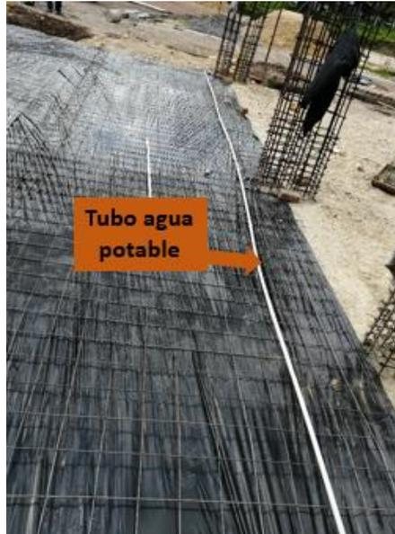
La placa de los primeros pisos tiene un espesor de 10 cm y un área de 54m<sup>2</sup>. Este se realizó en concreto de 21Mpa (3000psi) elaborado en obra, donde se consumieron aproximadamente 37 bultos de cemento de 50kg. Para contener la mezcla se utilizó aproximadamente 25.4 ml de Tabla de 20 cm de espesor.
