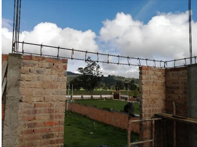
En este caso la separación de estribos no cumple con la indicada en los planos, haciendo el llamado al constructor para realizar la correcta separación, la cual se tuvo en cuenta dicha observación para la mejora.
