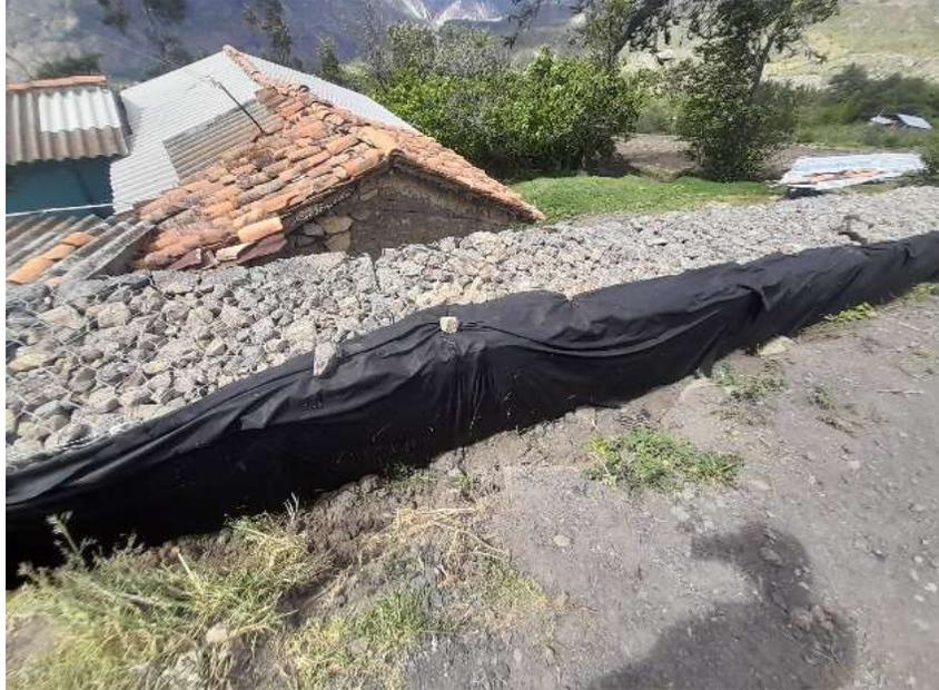
*Nota: en la siguiente figura vemos como se realiza la instalación del geotextil.*
