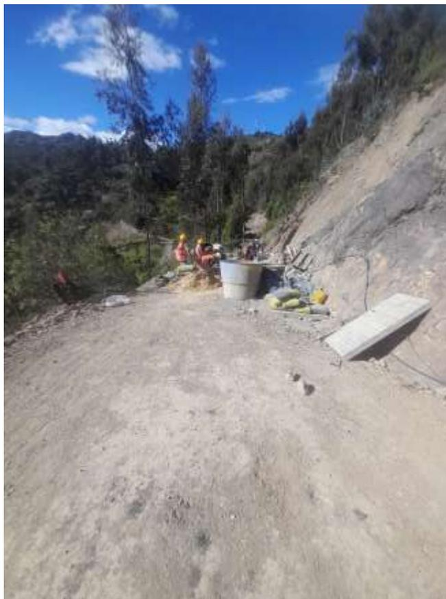
*Nota: En la siguiente figura vemos el inicio de la placa huella, como se observa la ampliación de la vía y excavaciones para las cunetas.*
