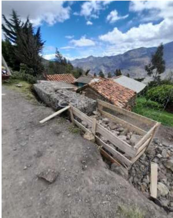
*Nota: en esta figura se muestra la construcción y elaboración de los gaviones.*
