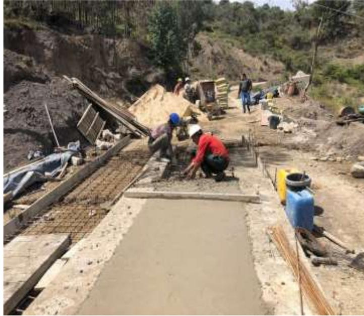
*Nota: En la siguiente figura vemos el avance y fundición de placa huella.*
