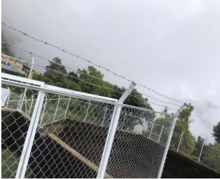
*Nota: en esta figura se muestra la instalación de alambre de púa calibre 14*
