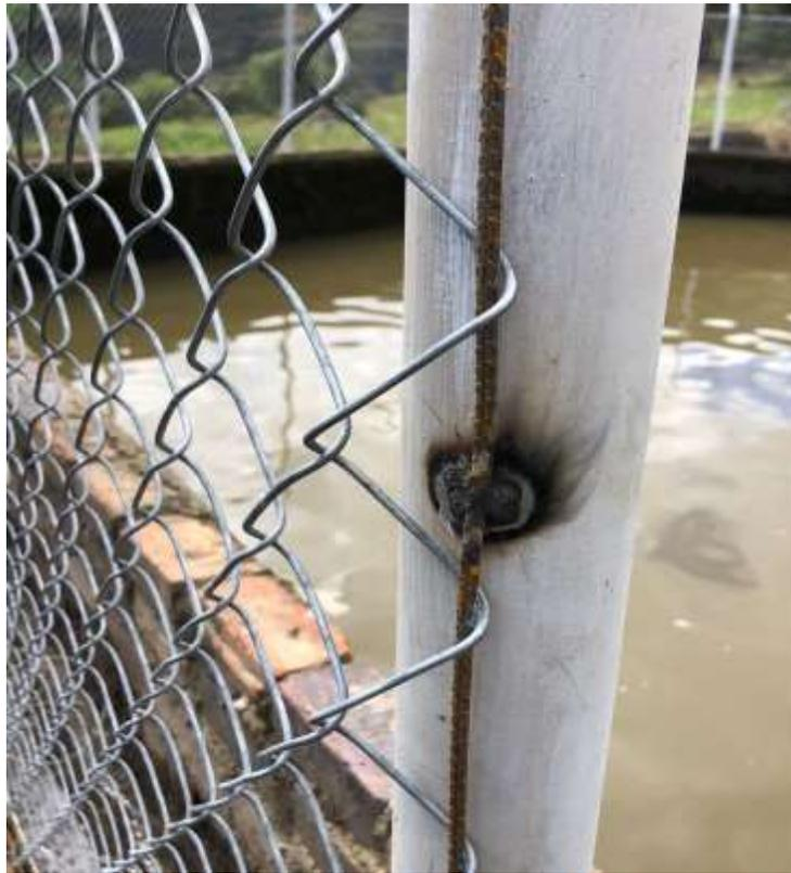
*Nota: en esta figura podemos observar la instalación y adecuación de la malla eslabonada por medio de puntos soldadura.*
