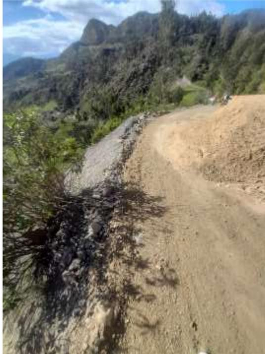
*Nota: En la siguiente figura notamos la presencia de material granular y ser aplicado o extendido en la vía, de forma manual para luego ser compactado.*
