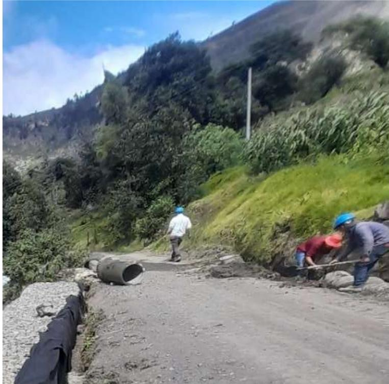
*Nota: En esta figura vemos como se realiza la excavación para la instalación de tubos de drenaje.*
