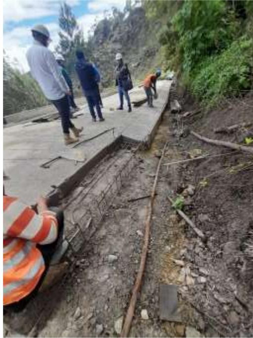
*Nota: En la siguiente figura vemos como se realiza el amarre de acero y excavación de cuneta.*
