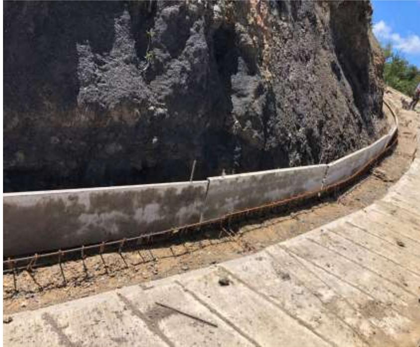
*Nota: En la siguiente figura vemos como se realiza excavación de cuneta.*
