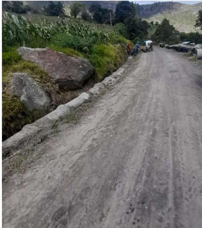
*Nota: En la siguiente figura vemos instalación de tubos en concreto de drenaje y el cubrimiento con material granular.*
