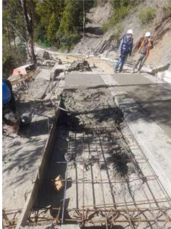
*Nota: En la siguiente figura se evidencia el amarre de las parrillas y vigas para fundir placa.*
