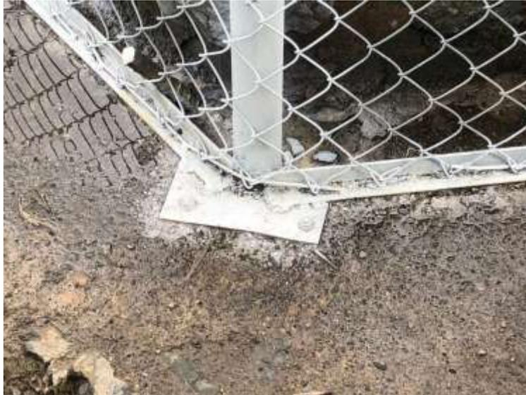
*Nota: En la siguiente figura verificamos la instalación de platinas por medio de pernos de anclaje de 3/8 metálicos.*
