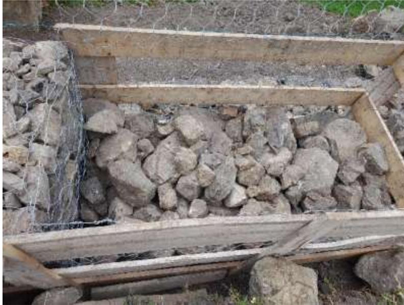
*Nota: Identificamos la instalación del material rocoso adentro de la malla como resultado final elaborar un muro.*
