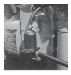
Fig. 11. Calentador de camisas. Imagen tomada de ficha técnica del calentador de camisas
