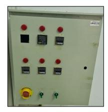
Figura 4 – Tablero de temperatura digital
