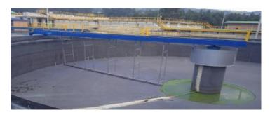
**Ilustración 13.** Sedimentador PTAR Veolia Tunja.
