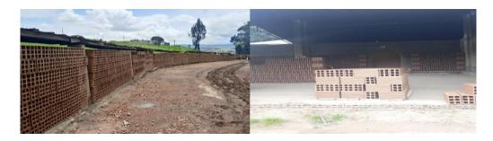
Ilustración 49-50. Secado natural de bloques
