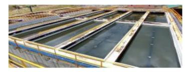
Ilustración 12. Reactores UASB PTAR Veolia Tunja.
