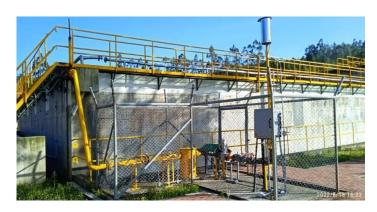
Ilustración 18. Quemador de biogás PTAR Veolia Tunja.
