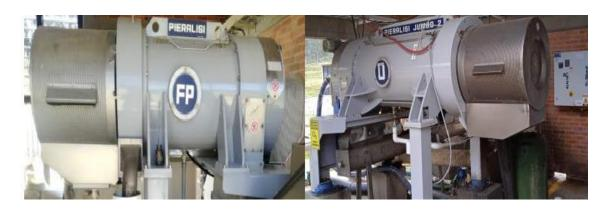
Ilustración 16-17. Centrifugadora o decanter PTAR Veolia Tunja.
