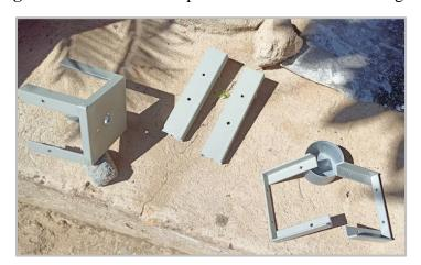
Figura 3.7.28: Pintado de partes con base anticorrosiva gris.
