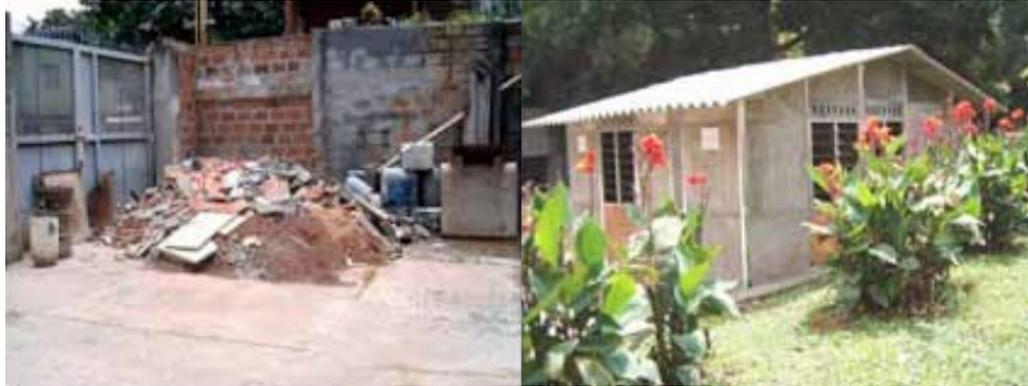
Fotografía de la izquierda, escombros generados en la empresa de prefabricados de Medellín, fotografía de la derecha vivienda construida con paneles de concreto reciclado. vivienda de interés social sostenible, VISS. Guarne. Antioquia STH. Sostenibilidad ecológica y humanismo. (figura). Recuperado (2022).
